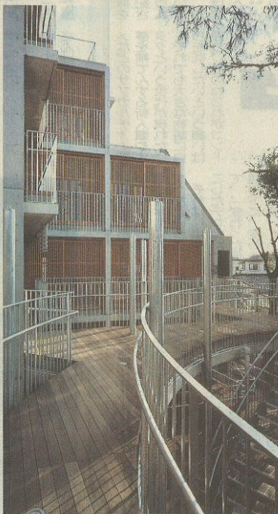
共用の渡り廊下と格子戸。この格子戸が生活の開放性とプライバシーを同時に保つ仕掛けとなっている
