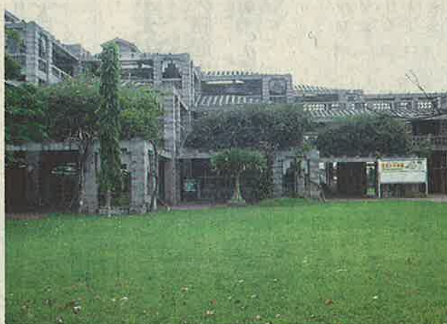
建築的な工夫によりクーラーに頼らないことを目指した名護市庁舎
