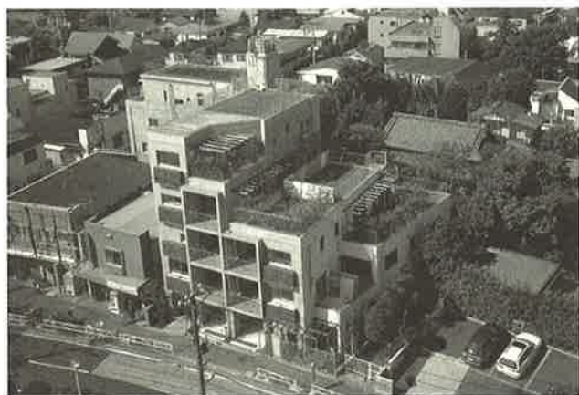
写真3 樗ハウスの全景 (撮影:坂口裕康)
