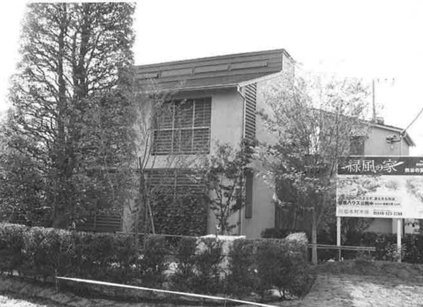
「緑風の家」の外観、樹木をたくさん植えている。屋根上部にはパッシブウィンドウ、窓には格子戸が確認できる
