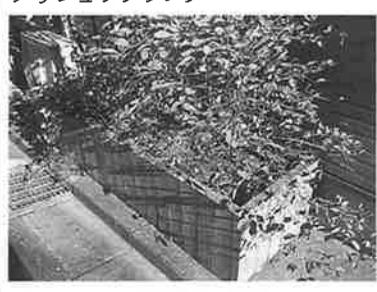
木調パネルの中を通したワイヤーで締めている。パネルの数でサイズを調整できる。
